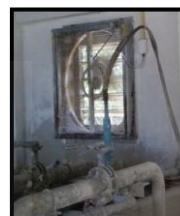
ติดตั้งพัดลมระบายอากาศ
